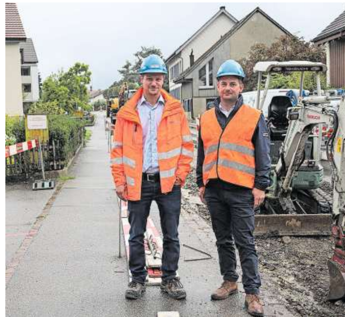
Reto Weidmann (links), Bauleiter, und Martin Utiger, Kreisingenieur, geben Auskunft zur Sanierung der Hauptstrasse. Bild: Deborah Bläuer
