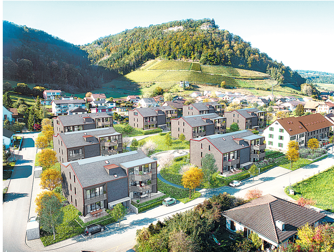
... bis 2024 entstehen hier acht kleine Mehrfamilienhäuser und vier Reihenhäuser. Das «Zimmermann»-Haus, rechts im Bild, bleibt bestehen, wird aber zu einem Haus mit drei Wohnungen umgebaut.
