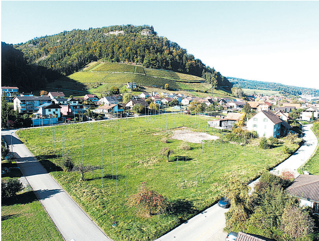
Auf der 1,1 Hektar grossen Fläche am Fuss des Geissbergs entsteht eine neue Siedlung. Ende Juli wurde mit dem Abhumusieren begonnen, ...
