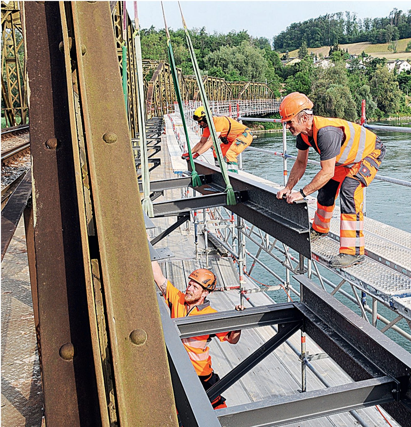
Die vorgefertigten Stahlelemente werden aus der Luft auf die erneuerten Stahlprofile gesetzt und direkt angeschraubt.
