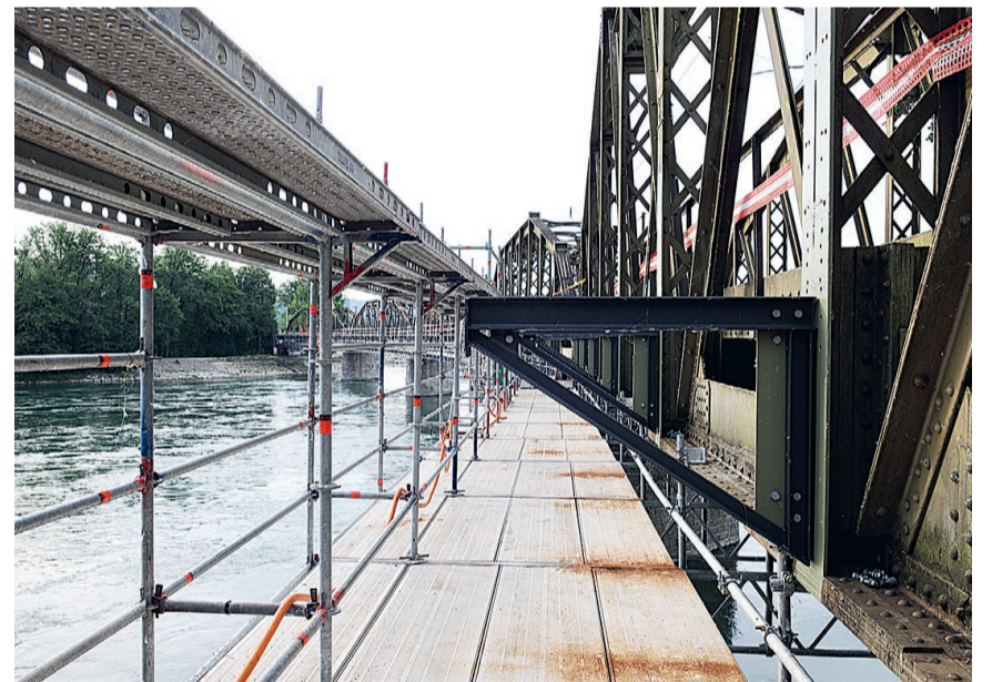
Blick auf die erneuerten und direkt am Brückenträger befestigten Profile, auf die die Stahlelemente des neuen Fussgängerstegs zu liegen kommen.
