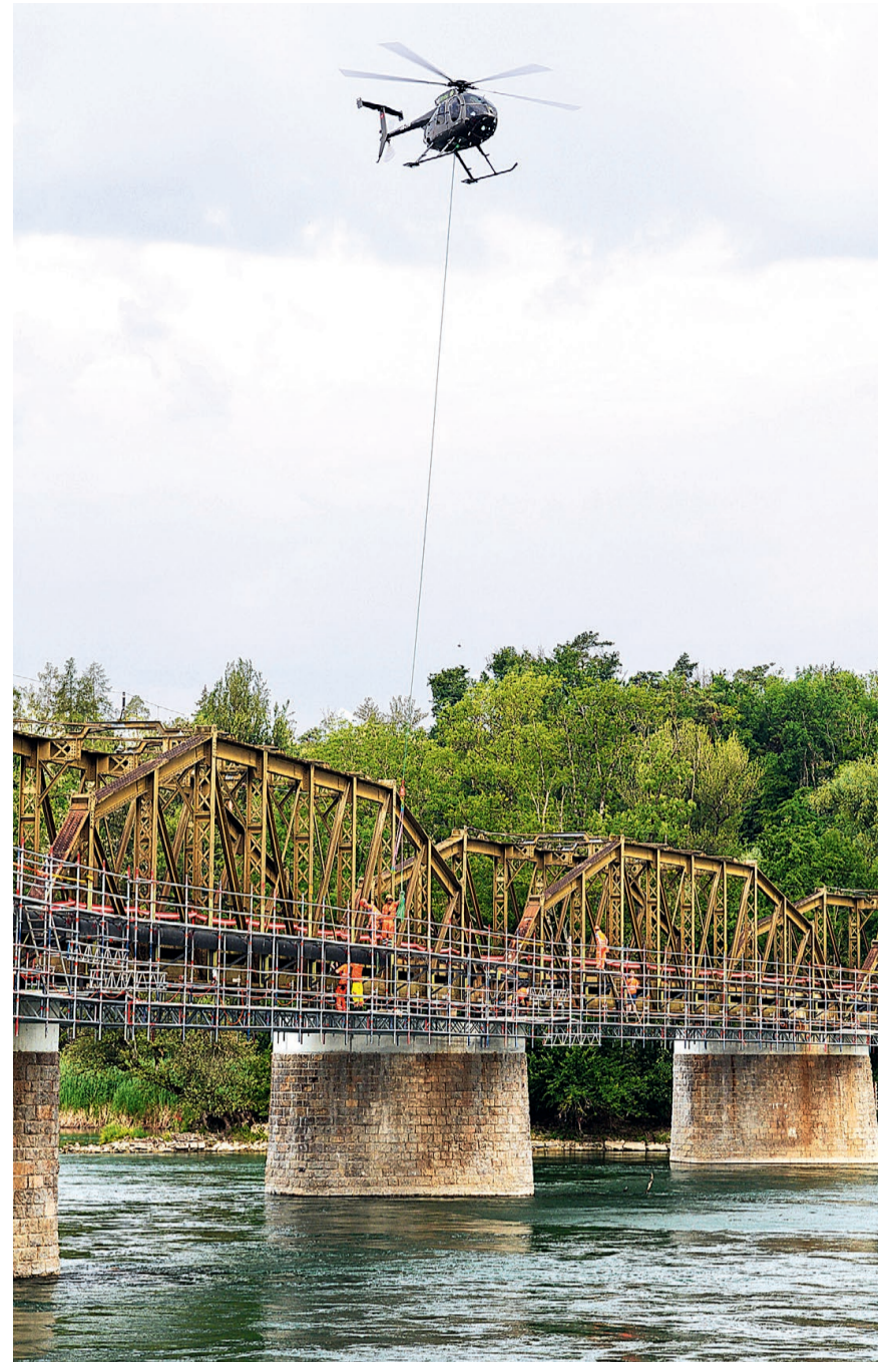
Die Elemente werden per Helikopter vom Koblenzer Ufer zur Brücke geflogen.
