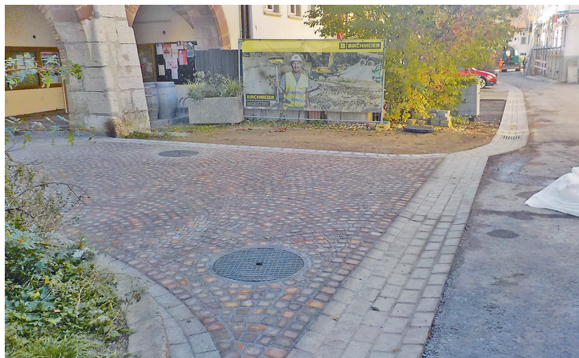
Gelungen Pflästererarbeiten beim Gemeindehaus.
