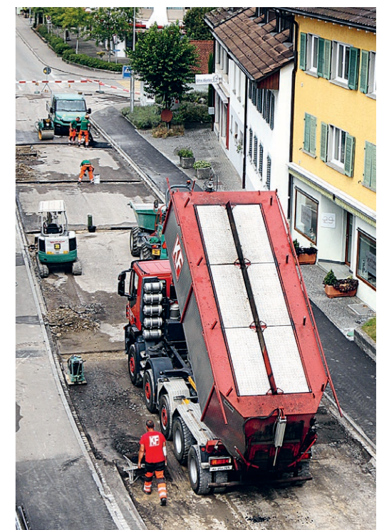
Erstes Belagsmaterial wird zugeführt.
