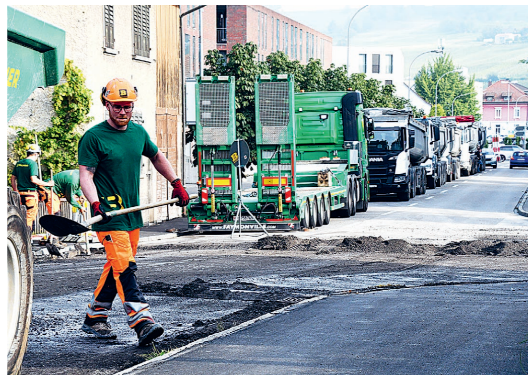
Lastwagen stehen zum Abtransport des weggefrästen Materials bereit.
