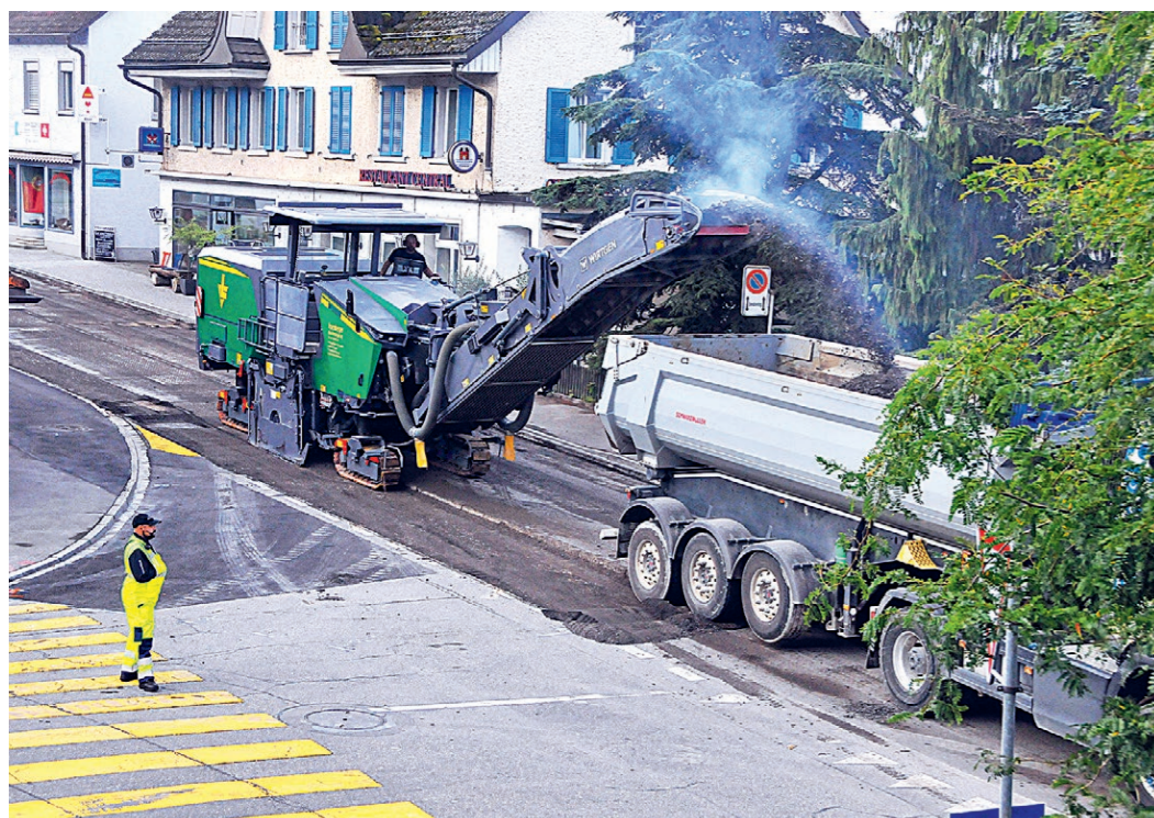
Wegfräsen, abtransportieren und zuführen – die aktuellen Arbeiten am Belag auf einen Blick: Dem alten Belag wird zu Leibe gerückt.
