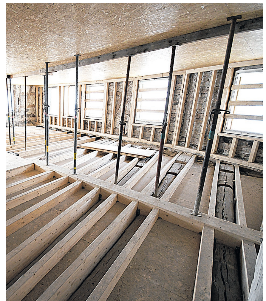
Im Verena-hof-Geviert ist der historische Holzbau, mit dem die alten Balken erhalten und der Brandschutz trotzdem garantiert werden soll, weit fortgeschritten.
