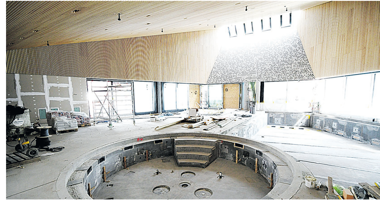
Im Innern ist in einem der «Finger» die künftige Badelandschaft des Thermalbads schon gut zu erkennen. Die Holzfassade ist vollendet und an der Fingerspitze ist das Signet «47» ebenfalls zu erkennen.
