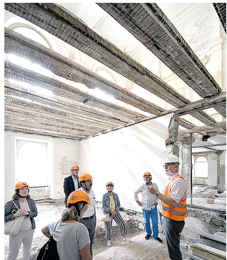
Auf einer Führung wurden Stiftungsratsmitglieder damals durch das Geviert geführt, hier stehen sie unter dem berühmten (aber bodenlosen) «Elefantensaal».
