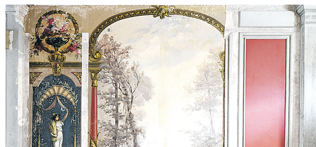
Mit dem Rückbau der Wände kamen im Eingangsbereich des Verena-hofs auch alte Malereien zum Vorschein, die erhalten werden sollen.
