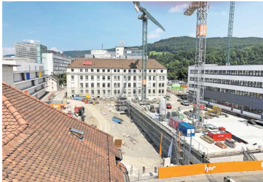
Die 1. Etappe des Parkhaus-Baus (rechts) ist beendet. Darauf wird der Brown-Boveri-Platz stehen. Bild: pkr
