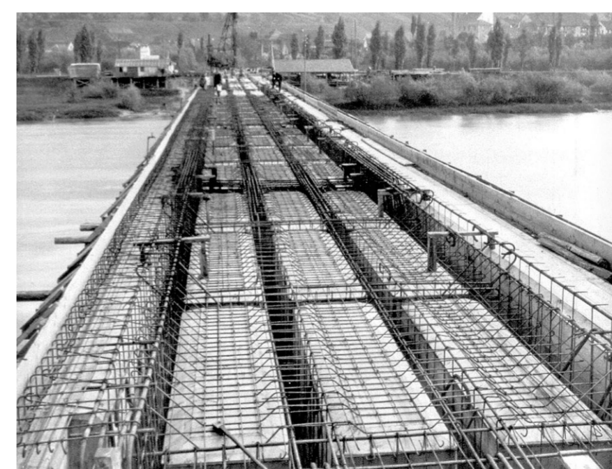
Die Armierungseisen sind gesetzt, die Brücke ist eingeschalt: Jetzt kann betoniert werden.
