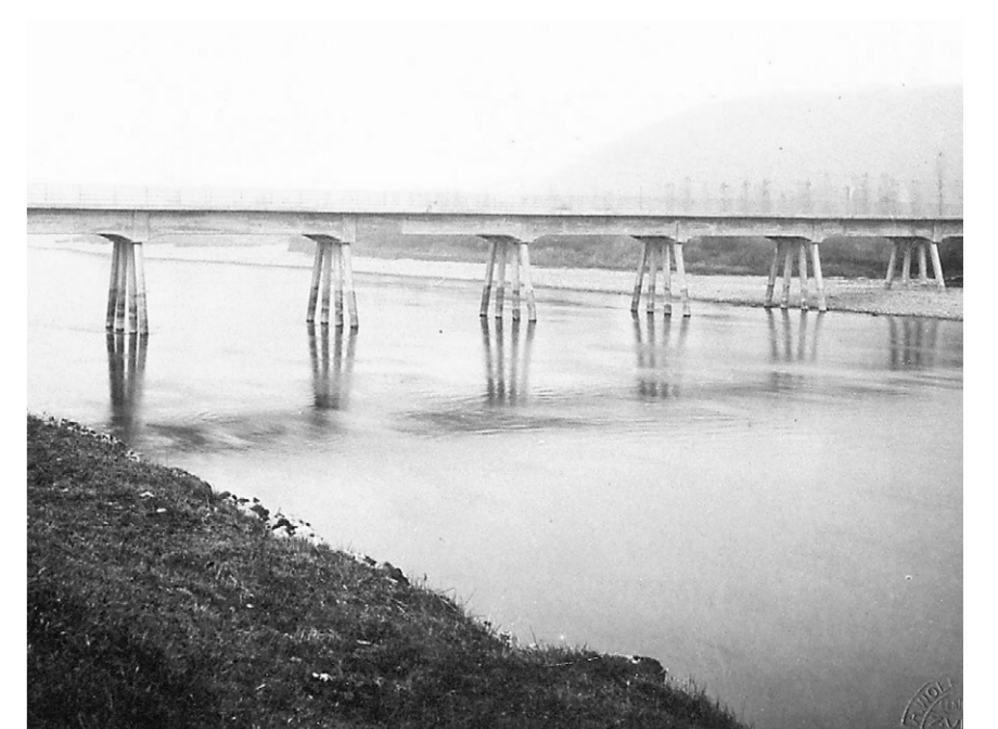
November 1920: Die Eisenbetonbrücke ist vollendet, theoretisch könnte jetzt das Anschlussgleis gesetzt werden – was aber nie geschieht.
