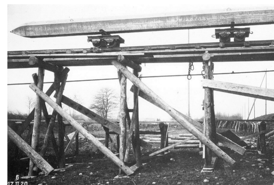
Die Pfähle werden auf Schienen zur Rammstelle geführt.
