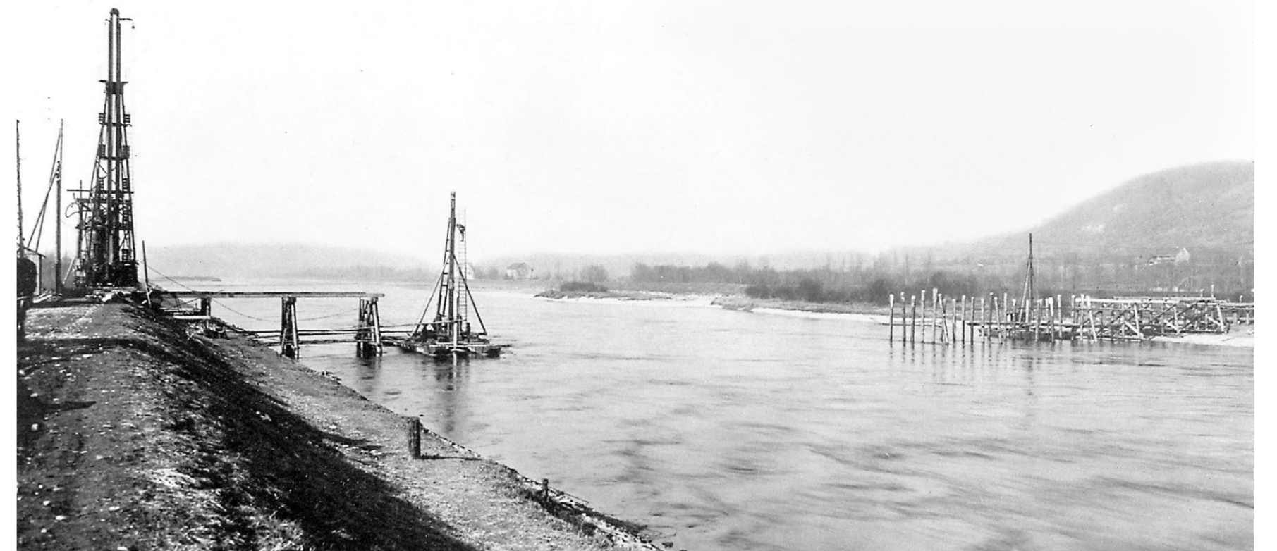
Im Februar 1920 wird mit dem Bau des Holzgerüsts der Brücke begonnen.
