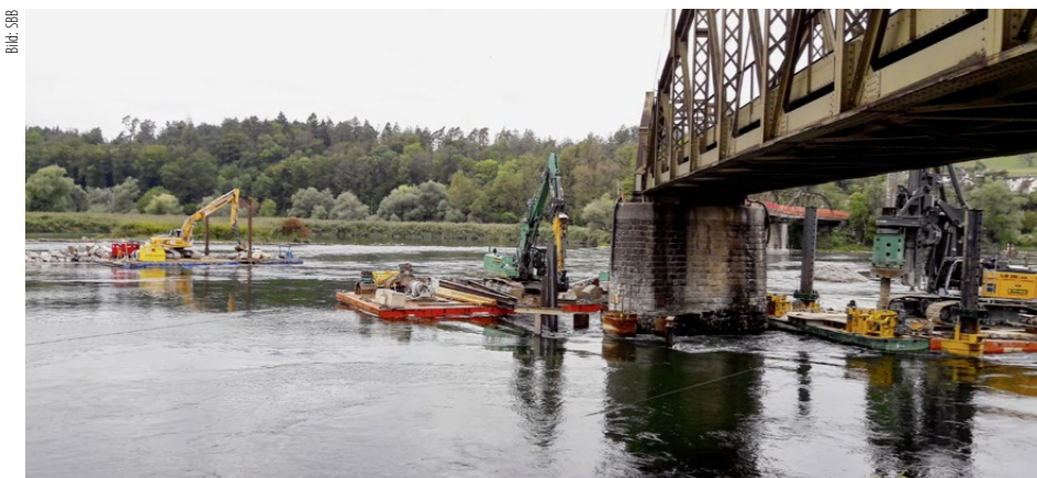
Die Arbeiten erfolgen von vier Pontons aus gleichzeitig. Eines ist für den Materialtransport bestimmt.
