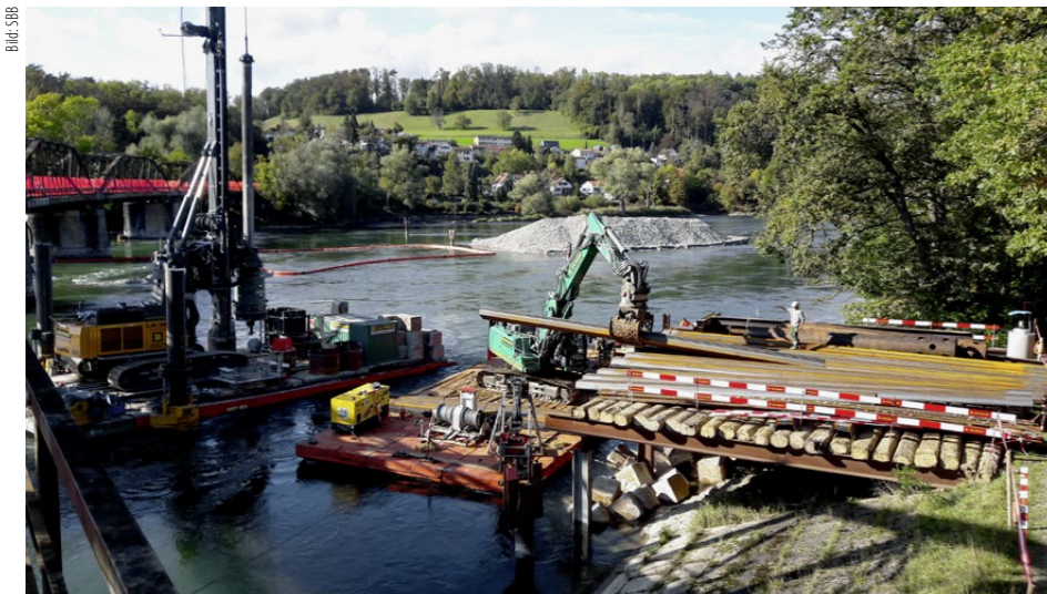
Ein zweiter, kleinerer Installationsplatz liegt gleich unter der Brücke und hilft beim Warenumschiag.
