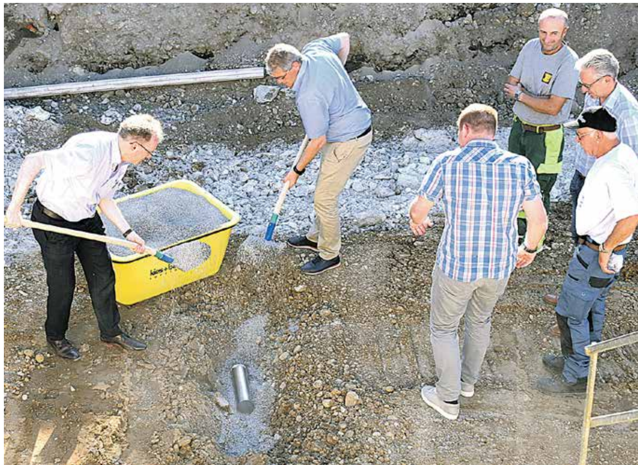
Andreas Edlmann und René Huber vollziehen die Grundsteinlegung und kommen beim Schaufeln ins Schwitzen.
